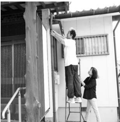
台風で損傷した家屋の修理
