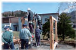
↑柱を立て始める所
