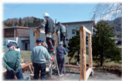
↑柱を立て始める所
